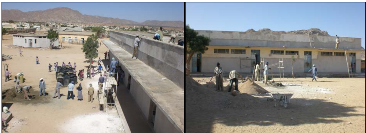
Die Selam-Schule während der Renovierungsarbeiten
