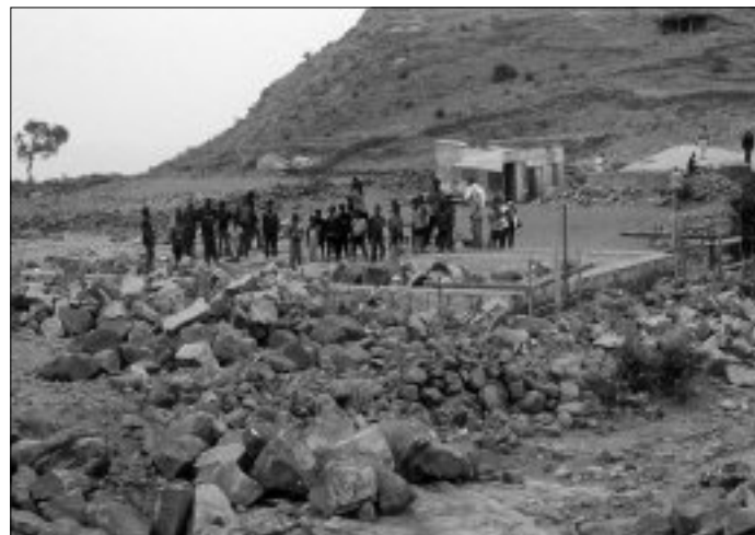
Stein auf Stein: Unser Schulprojekt in Adi Belsey nimmt Formen an. Die Bevölkerung ist aktiv an den Bauarbeiten beteiligt. Ein ausführlicher Bericht folgt in der nächsten Ausgabe von REDIET.
