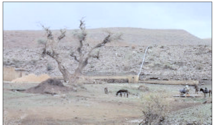
Die neue Viehtränke in Kene Hayela wird über eine Überlauf-Leitung gespeist. Damit ist die Trennung der Wasserstelle für Mensch und Tier und damit Hygiene sichergestellt
