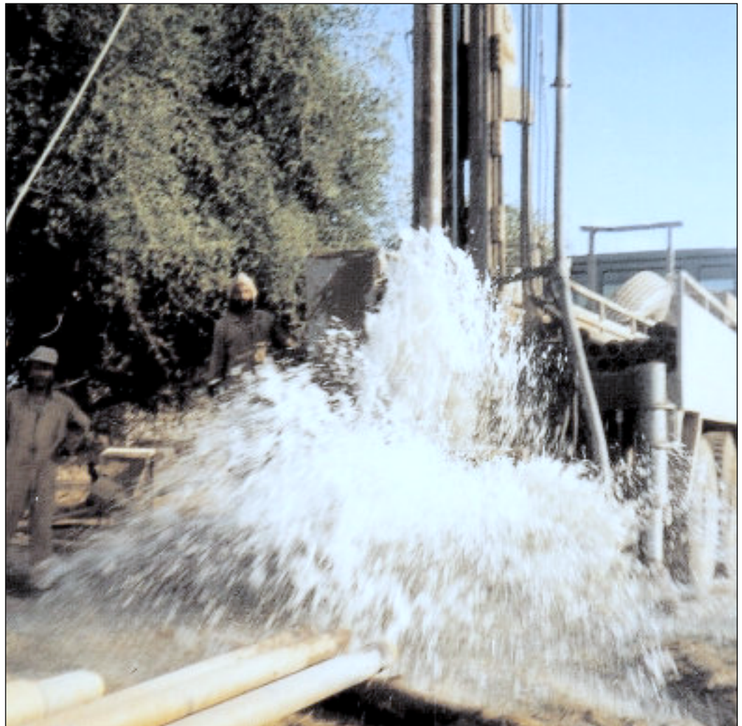
Erfolgreiche Bohrung in Kena Hayela. Diese Quelle wird den Hochbehälter mit Trinkwasser speisen
