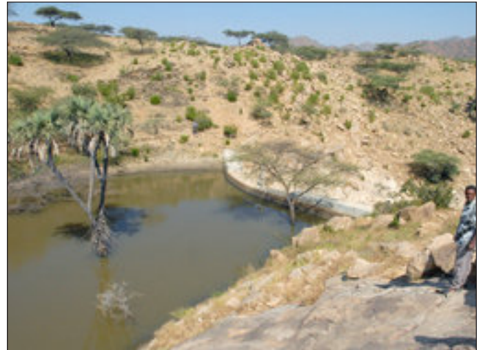
Vier Staudämme sichern 100 000 Kubikmeter Wasser. Foto: mz
