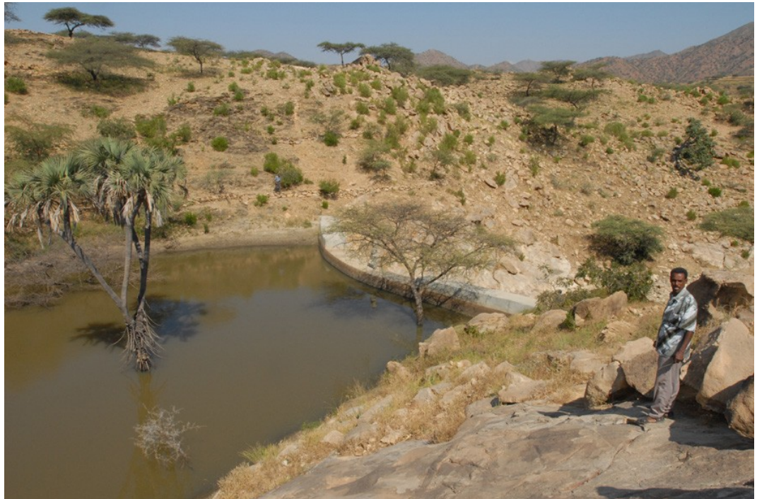
Damm Nummer vier
