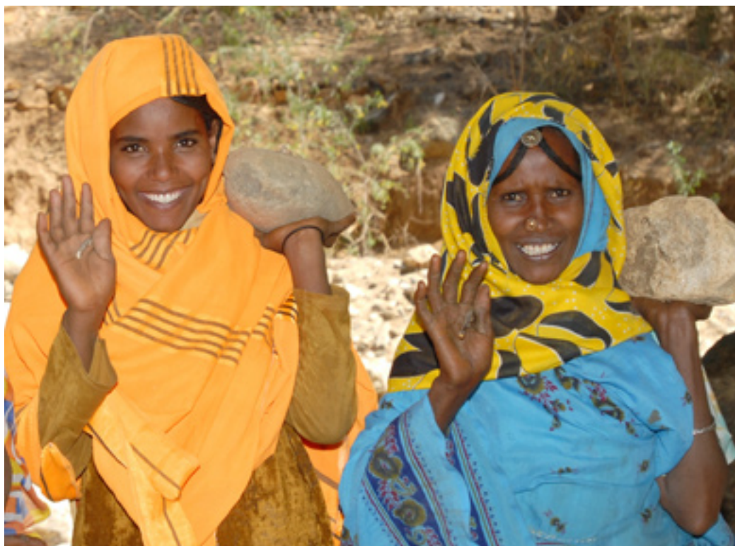
Vier ganze Dörfer sind auf den Beinen und sammeln Steine für den Bau von Staudämmen und Flutbrechern. Die Menschen sind sehr dankbar für die Hilfe und arbeiten begeistert mit. Foto: Zimmermann
